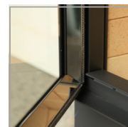
rama drzwi od wewnątrz wykończona stalą nierdzewną
