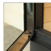
rama drzwi od wewnątrz wykończona stalą nierdzewną
