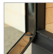
rama drzwi od wewnątrz wykończona stalą nierdzewną
