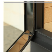
rama drzwi od wewnątrz wykończona stalą nierdzewną
