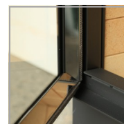
rama drzwi od wewnątrz wykończona stalą nierdzewną
