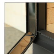
rama drzwi od wewnątrz wykończona stalą nierdzewną
