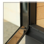
rama drzwi od wewnątrz wykończona stalą nierdzewną
