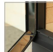
rama drzwi od wewnątrz wykończona stalą nierdzewną
